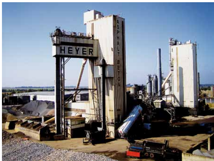
Bild 4: Beim mittelständischen Familienunternehmen hat sich die Aufbereitung von Bitumendachbahnen zu einem eigenen Produktionszweig entwickelt
