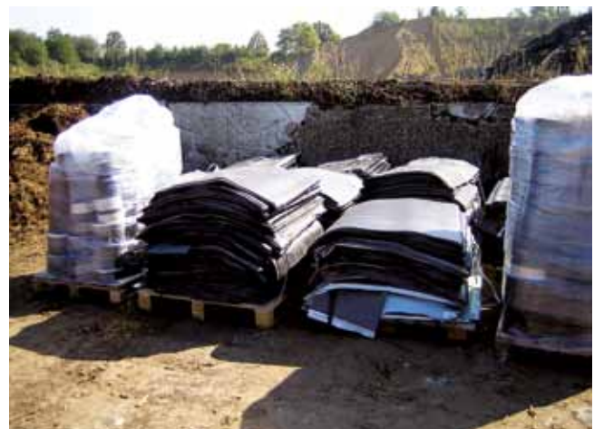
Bild 2: Bei der Herstellung von Dachbahnen kommt es zu Fehlchargen, Stanzresten, An- und Abfahrrollen sowie überlagerter Ware
